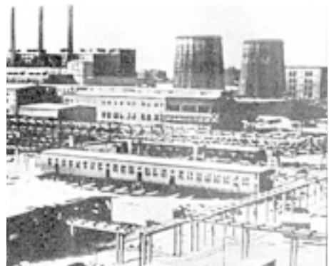
Ett av I. G. Farbens industrikomplex
